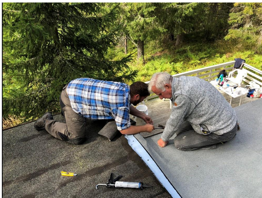
Øystein Dahl Johansen og Per Tuft reparerer hyttetaket 29.08. Foto: Svein Aasen.
