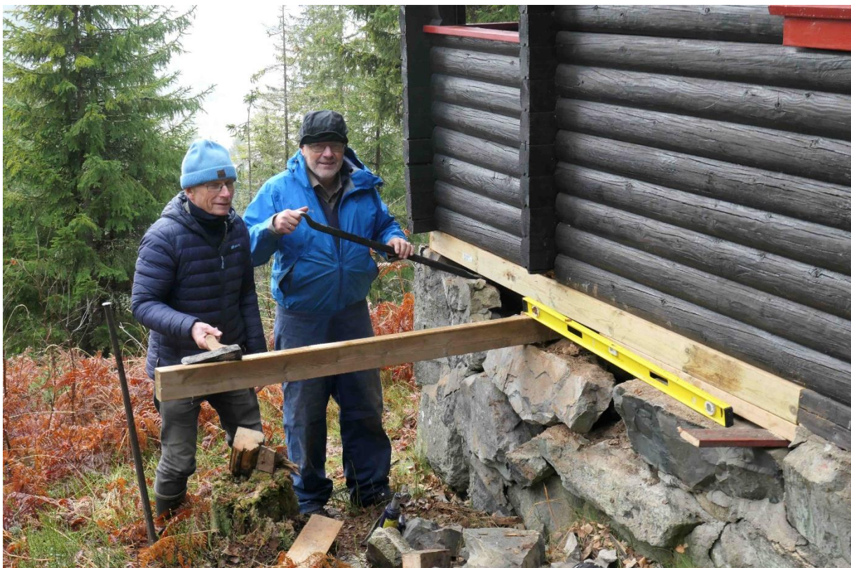
Reparering av hytta 10. november. Svein og Lars Peder er i full gang. Foto: Kjersti Aasen
